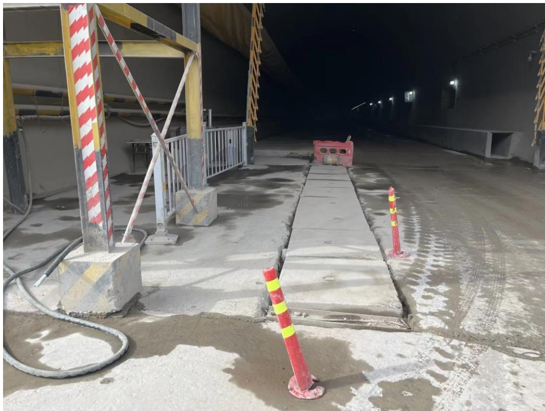
图 7.2 隧道中央排水沟现场照片
