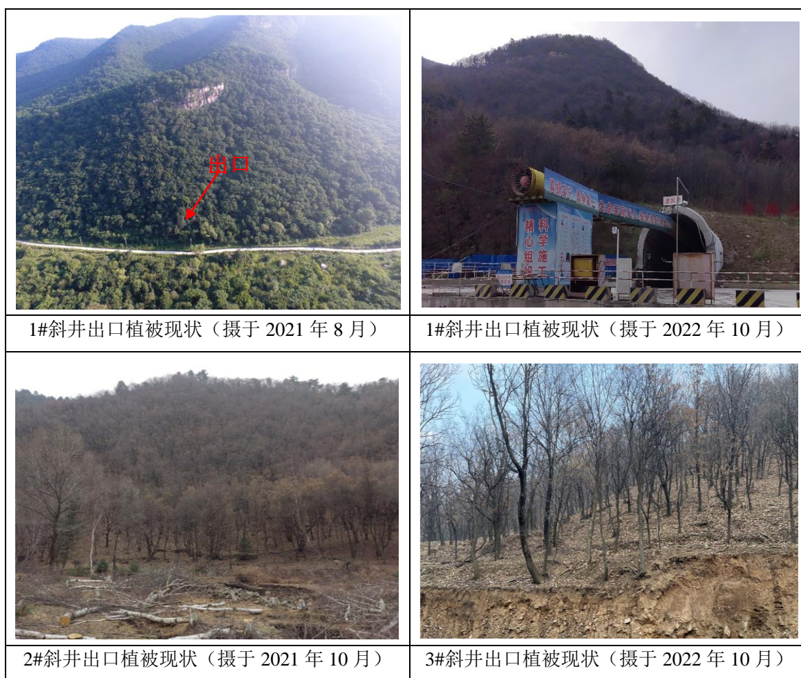
图 4.2 斜井出口植被现状
