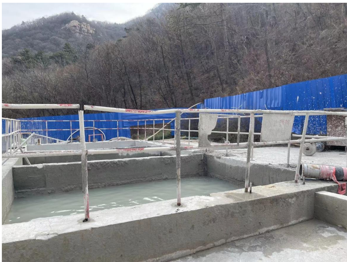
图 7.3 1#斜井隧道涌水沉淀池现场照片
