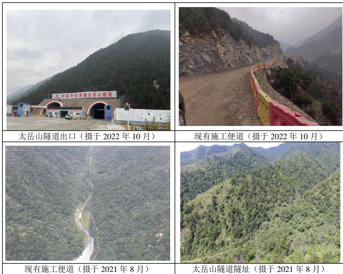
图 4.4 本项目保护区路段工程生态现状
