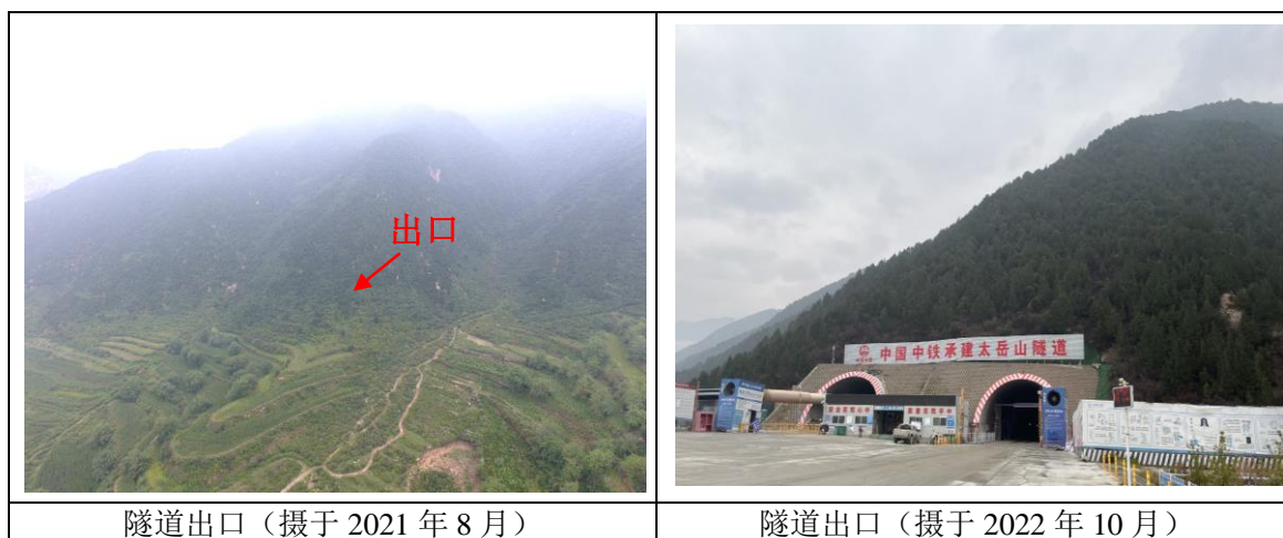
图 4.1 太岳山隧道进、出口植被现状
